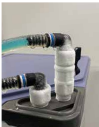
結露対策カバー未装着
